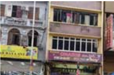
3 Shophouses at Jalan Tun Tan Siew Sin
